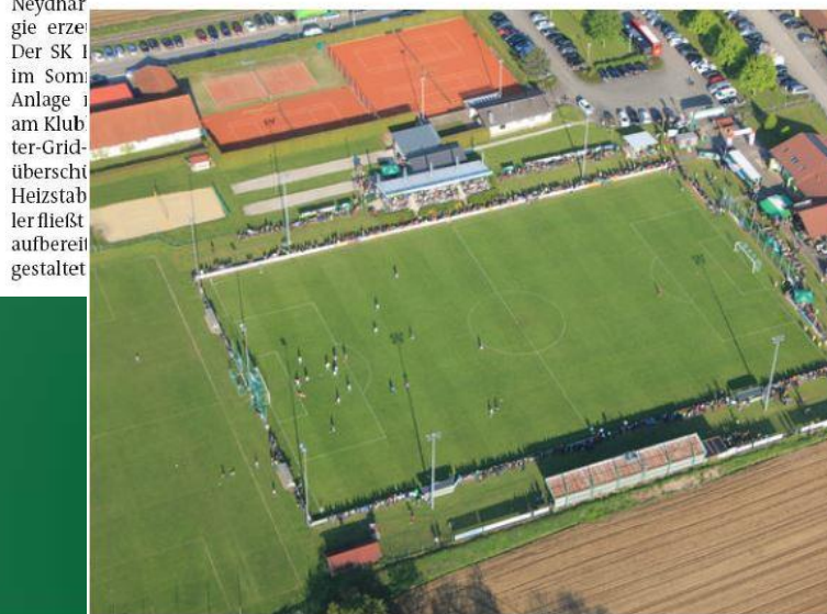
Die Photovoltaik-Anlage am Dach des Wimsbacher Vereinsheims versorgt die gesamte Stadionbeleuchtung mit Strom. (Foto: Bammer)
